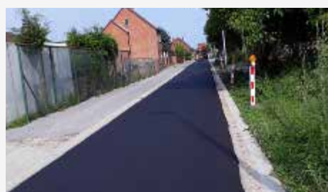
Een beeld na aanleggen van de toplaag asfalt op de Betserberaan.
